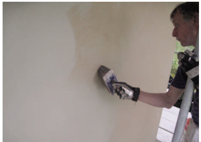
Neuer Kalkanstrich pigmentiert al fresco nass in nass den frischen Deckputz aufgetragen
