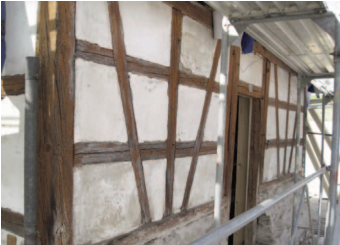
Ursprünglicher Kalkanstrich auf Riegelfeldern
