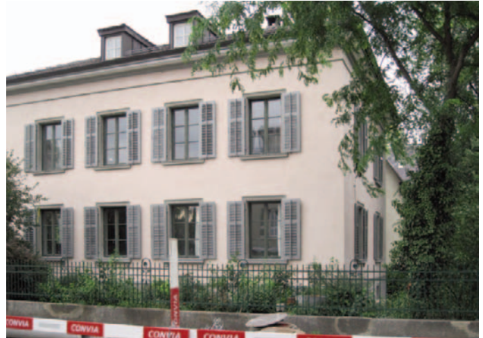
Fertig gekalkte Fassade
