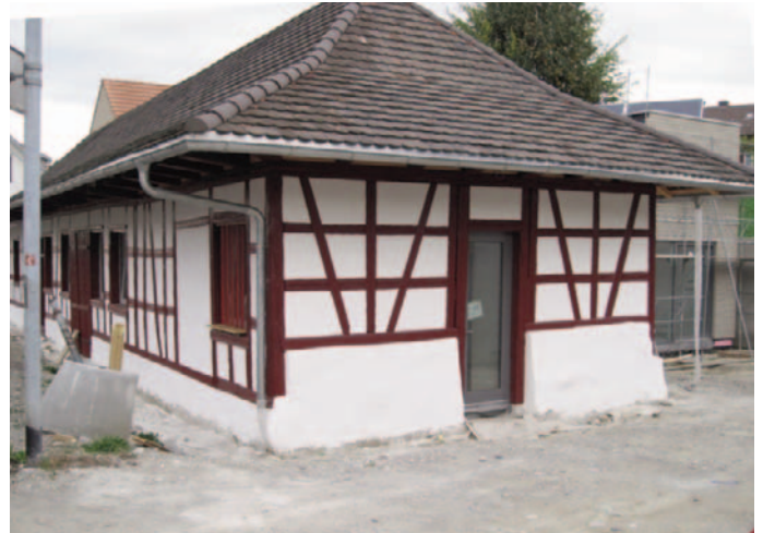
Fertig gekalkte Riegelfelder und Sockel, 2 Anstriche
