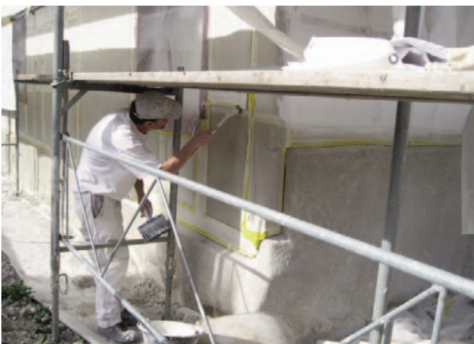
Kalkanstrich al fresco nass in nass auf den frischen Deckputz aufgetragen
