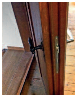
Bild 1: Neue Estrichtüre in Mehrfamilienhaus von 1902 mit alter Türe als Doppel vorgesetzt. Bild 2: Fuge unter Sockelbrett hinter Sockelleiste, die mit Seidenzöpfen gedichtet werden kann. Bild 3: Rolladenkasten in Wohnhaus von 1912; im oberen Teil drang durch einen 6 cm hohen Spalt kalte Aussenluft in den Deckenhohlraum und kühlte die Gipsdecke massiv aus.
