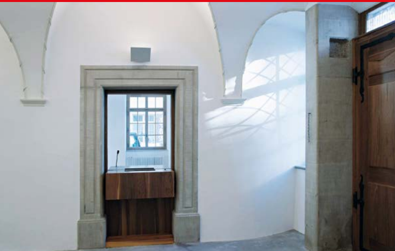
1 Rathaus Trogen, Renoviert 2013. LED-Deckenfluter mit präziser Lichttechnik beleuchten die Decken direkt, den Raum indirekt (Hellraum). Foto: Emanuel Sturzenegger
