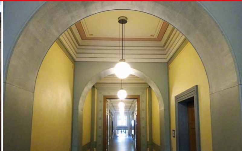
2 Gang Kantonsschule St. Gallen, 1855, Renoviert 1999. Die klassischen Glasopal-Pendelleuchten erhellen den Raum gleichmässig mit diffusem Licht. Foto: Adrian Hostettler
