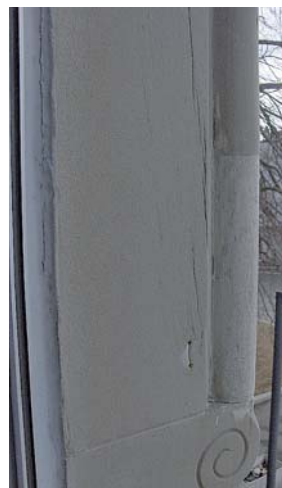
Schadensbilder an Fenstergewände: Risse, Absanden, hohl liegende Schalen, unschöne alte Mörtelergänzungen (Rundstab).
