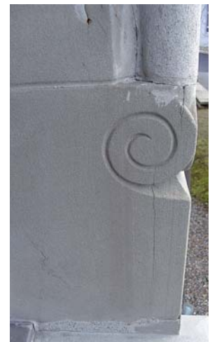
Schadensbilder an Fenstergewände: Risse, Absanden, hohl liegende Schalen, unschöne alte Mörtelergänzungen (Rundstab).
