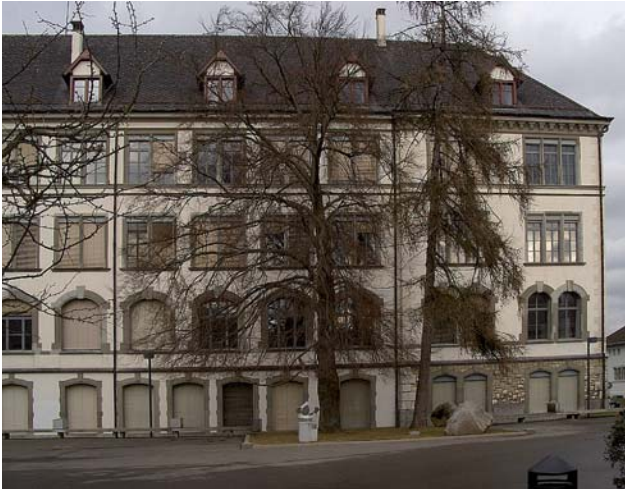
Ostseite der Kantonsschule in Schaffhausen, vor der Eingerüstung.
