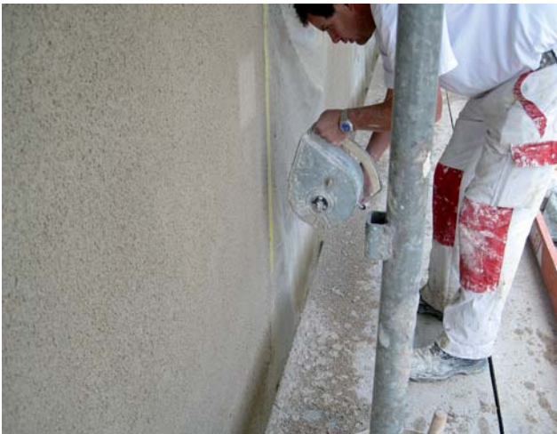
Der blecherne Wormser wird links getragen. Die rechte Hand betätigt die Kurbel zum Antrieb der innen liegenden Drehbürste.
